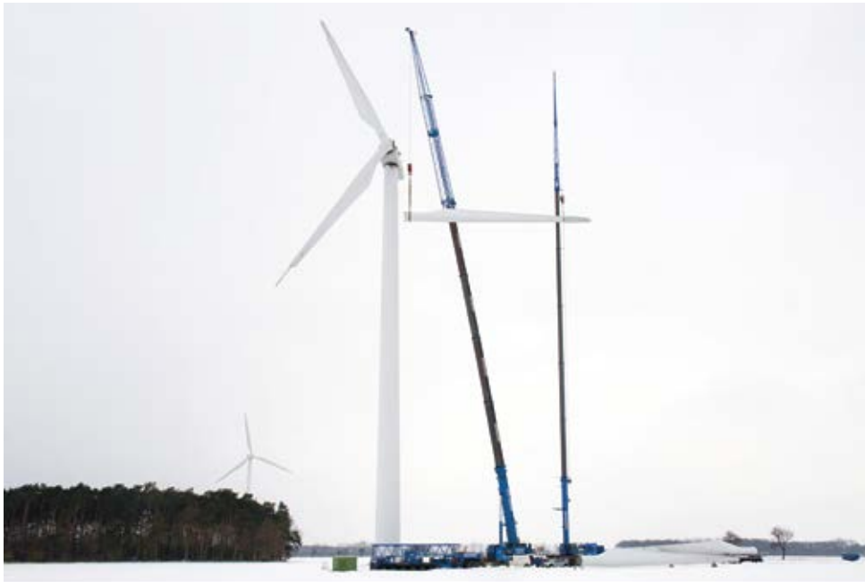
Rotorblatt-Montage an einer WEA
